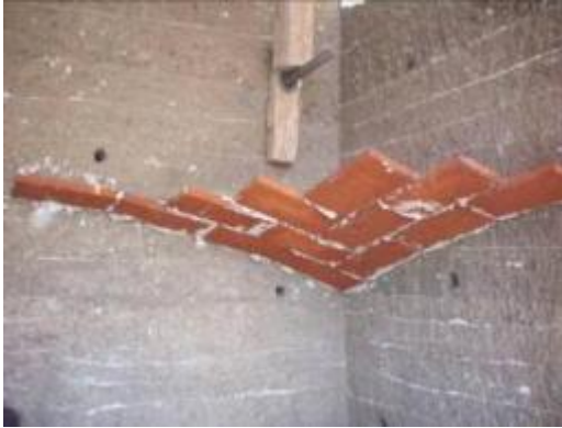
Foto 3. Intersección de ladrillos en bóveda catalana.
