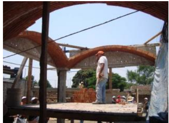
Foto 2. Proceso constructivo bóveda de ladrillo recargado.
