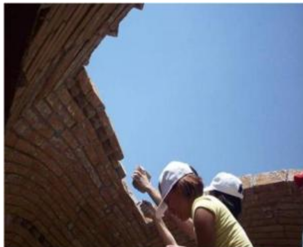
Foto 5. Estudiantes en la construcción de bóveda de tierra, en Soledad Etla, Oaxaca.
