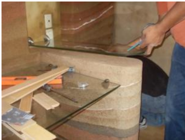
11.- Y finalmente se protege con silicato de sodio
