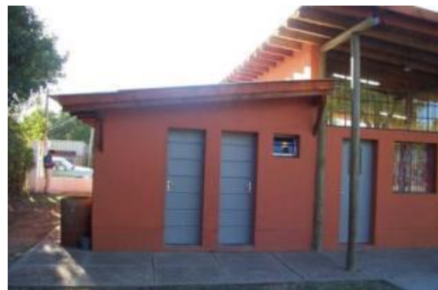
IMAGEN DE LA FACHADA POSTERIOR. SE OBSERVA EL ZÓCALO HIDROFUGADO. Informe: Arq. Rosario Etchebarne coordinadora proyecto de investigación en bioconstrucción.
