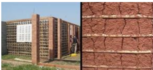
Figura 5a. Etapas de execução da parede interna de Taipa de mão.
