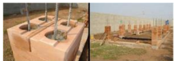
Figura 3. Coluna dentro dos tijolos de solo-cimento.
