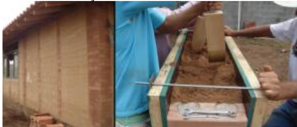
Figura 4. Taipa de pilão executada e durante a sua execução.
