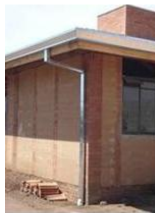
Figura 9. Sistema de calhas para captação de água da chuva e cisterna em fase de construção.
