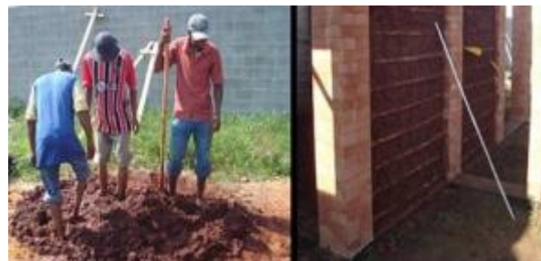
Figura 5b. Etapas de execução da parede interna de Taipa de mão.
