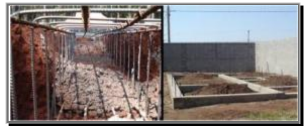
Figura 2. Fundação durante andamento e finalizada.
