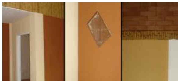
Figura 6. Cores das tintas a base de terra e detalhes de acabamento no interior da residência.
