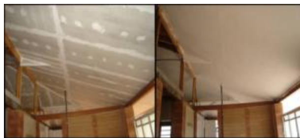
Figura 7. Detalhe do forro de tetra pak antes e depois do acabamento.
