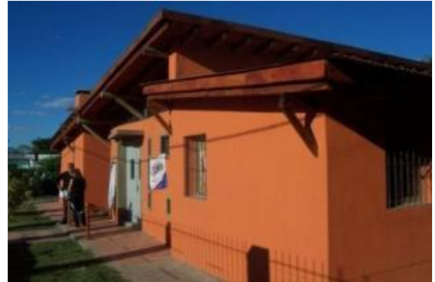
FACHADA PRINCIPAL. SE OBSERVA EL GRAN TECHO Y EL ESPESOR DE 30 CM DE LAS PAREDES, LO QUE POSIBILITA UN BUEN COMPORTAMIENTO TÉRMICO. EL MURO CURVO DE ACCESO ES EN BTC (bloque de tierra comprimida). El uso de cemento en esta construcción ha sido mínimo. Se ha empleado mucha madera y tierra, materiales de bajo impacto ambiental en su proceso de transformación.
