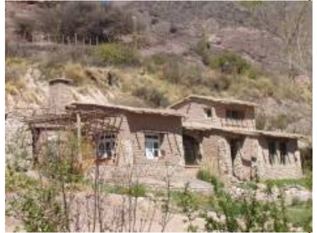
Vivienda nueva de piedra, adobe y madera (quebrada de Juella, proy. N.José)
