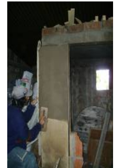
Construcción y evaluación de prototipos de revoques sobre paredes de mampostería de BTC y ladrillo cerámico hueco.
