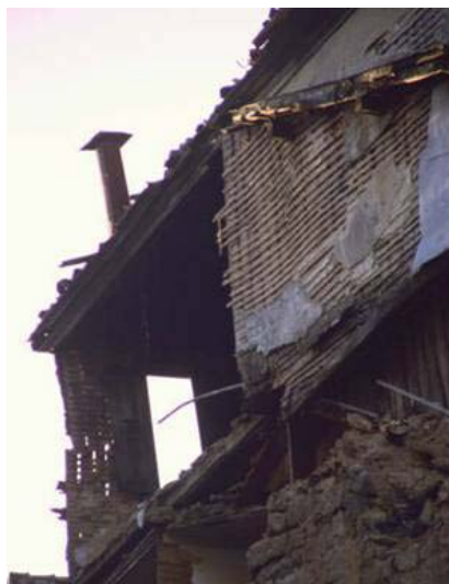
Muros exterior realizado con listones. Viseu, Portugal
