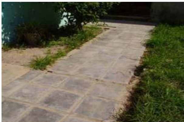
Piso de prueba en Bancalari (Norte del Gran Buenos Aires). Baldosas de (25 x25 x 2,5) cm con empleo de tierra tosca estabilizada.
