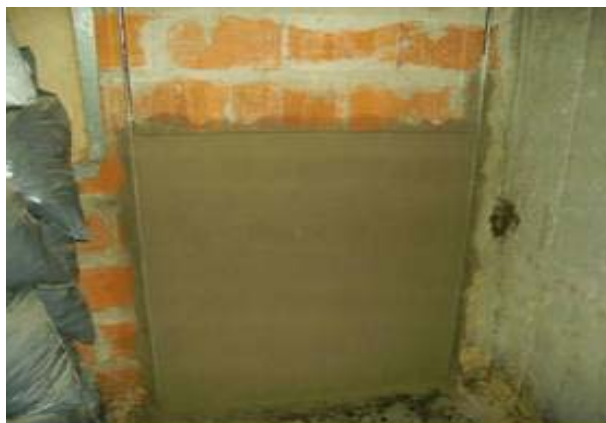
Revoques de suelo-cemento y suelo-cemento-cal sobre pared de ladrillo cerámico hueco en Florencio Varela (Sur del Gran Buenos Aires).
