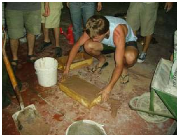
Práctica de fabricación de adobes por alumnos de la Facultad de Arquitectura, Diseño y Urbanismo (UBA), Buenos Aires. Adobes tradicionales con molde de madera
