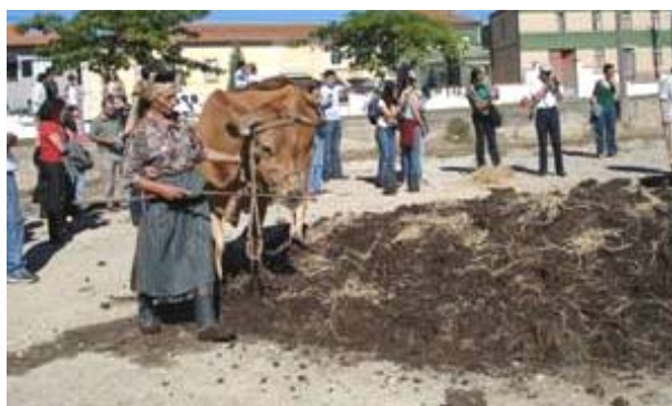
A vaca ajuda os adobeiros a misturar a terra com palha
